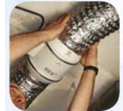
Acoplar los conductos
